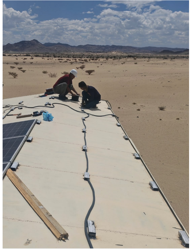
أعمال التثبيت وتجهيز مسارات التوصيل
